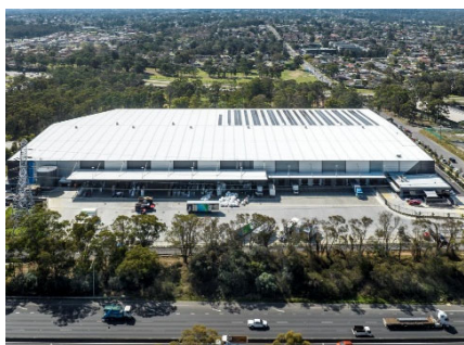
シドニー 倉庫・配送センター
