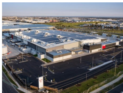
メルボルン 小売業倉庫
