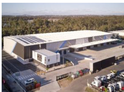
メルボルン 小売業倉庫
